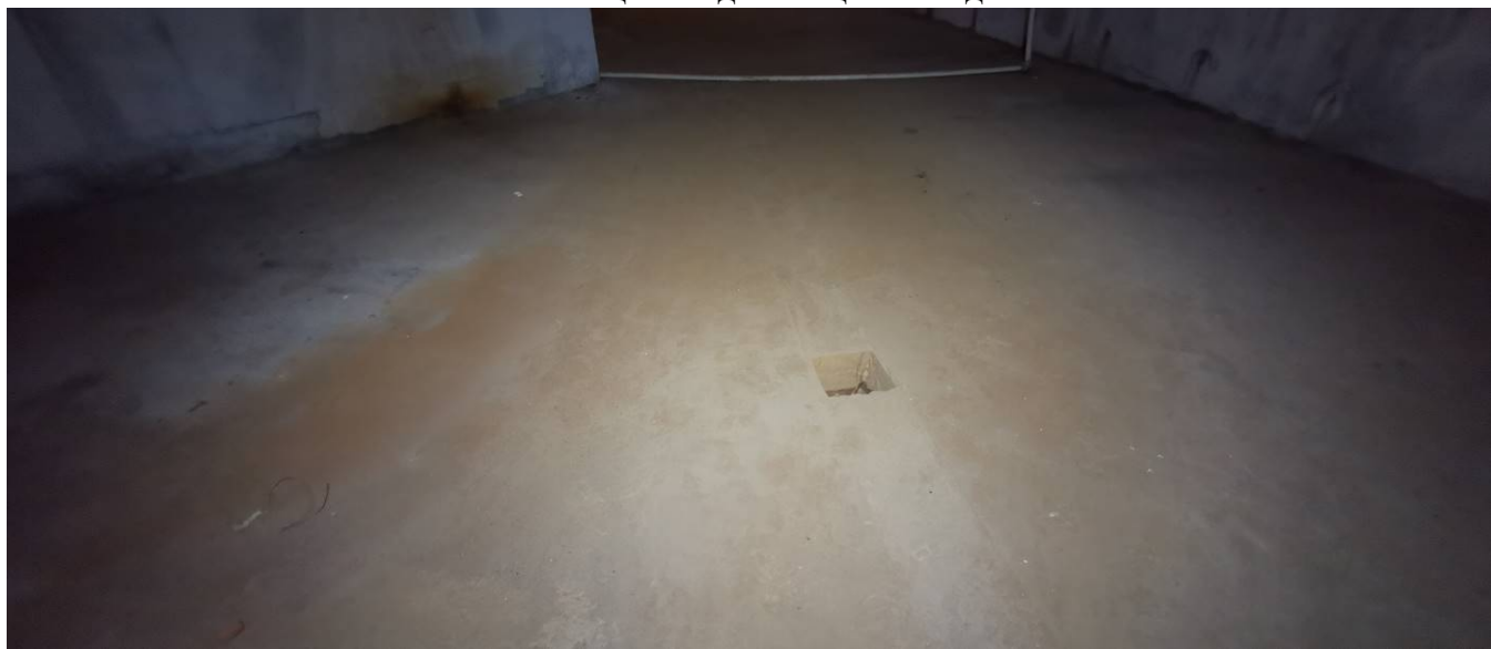
Фото 3. Общий вид плиты пола по грунту в подвале
