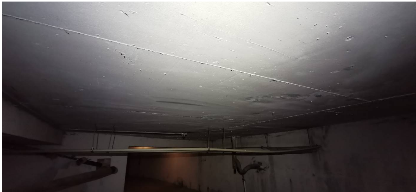
Фото 4. Общий вид монолитного железобетонного перекрытия
