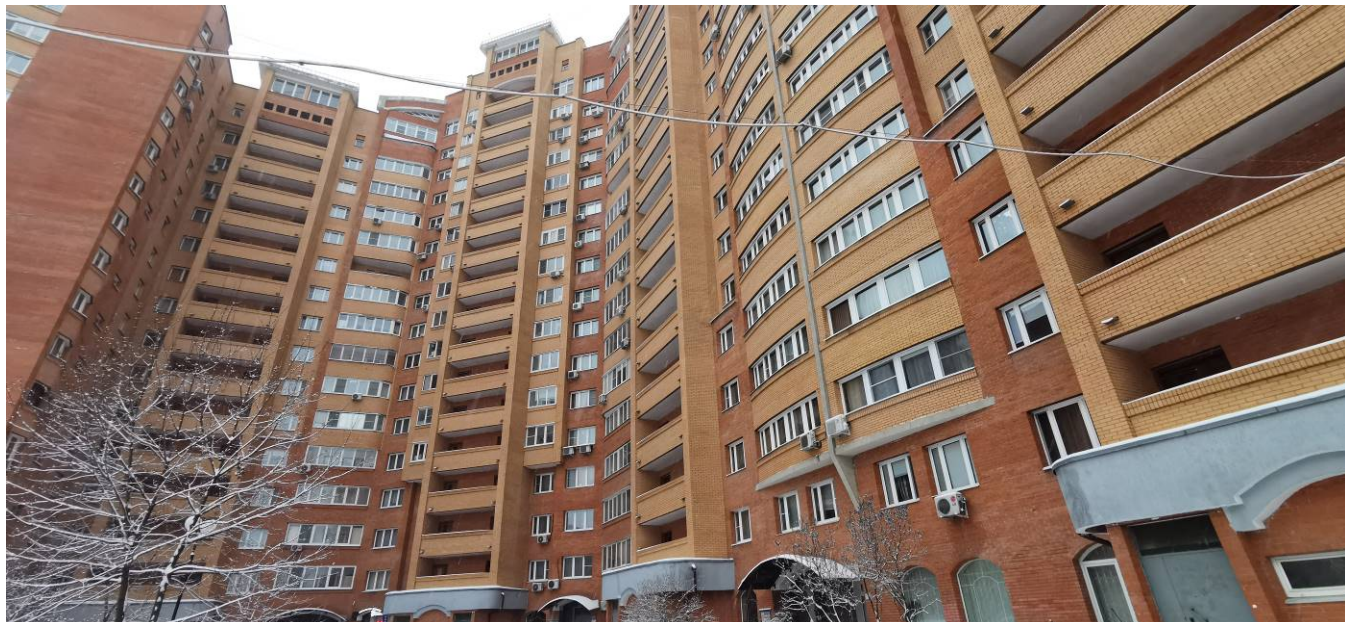
Фото 1. Общий вид фасада здания со стороны двора
