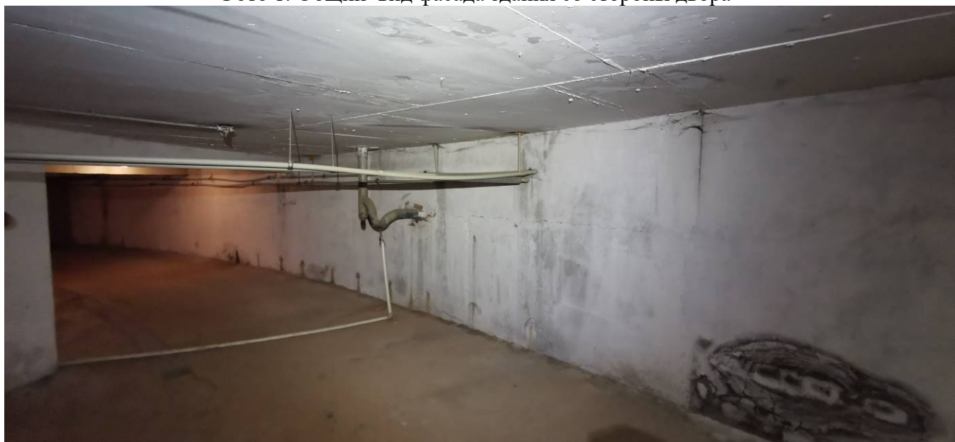
Фото 2. Общий вид помещений подвала
