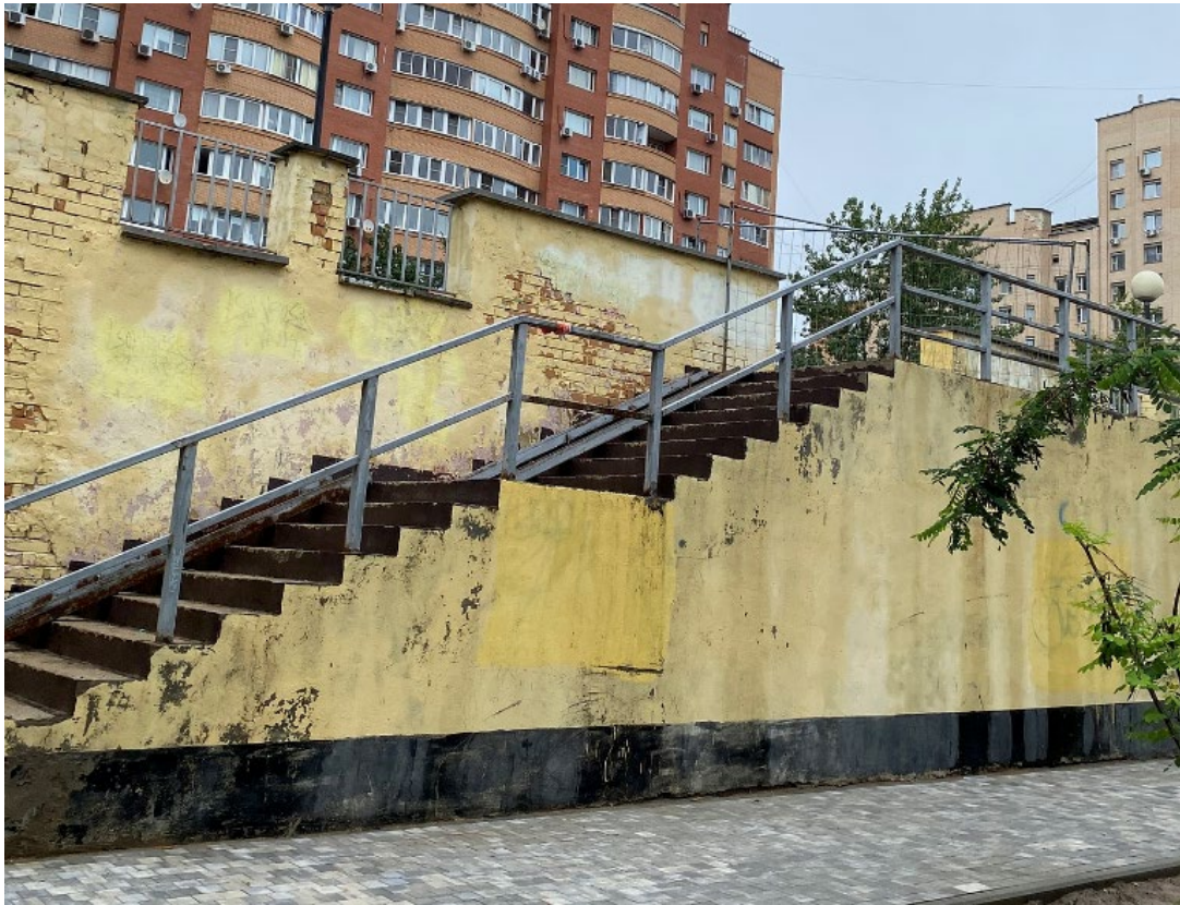
Фото №11. Наружная лестница подъема на площадку.
